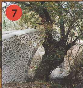
Latsagako zubia Puente de Latsaga.
